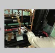
冷媒配管分解
