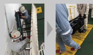
分解した部材を船内通路を通じて搬入
