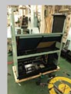
電装BOX 取外し
