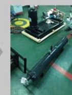
凝縮器・圧縮機取り外し
