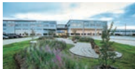
同社の工場「ダイキン テキサス テクノロジーパーク」
