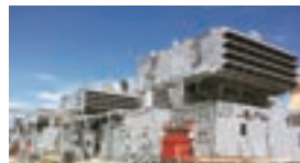
ガスタービン用吸気・換気システム
