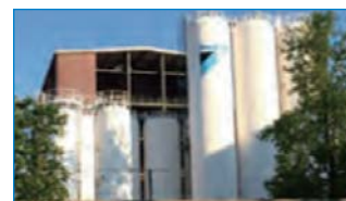
冷媒の回収・再生・破壊のスキームづくりにおけるドイツの再生破壊設備
