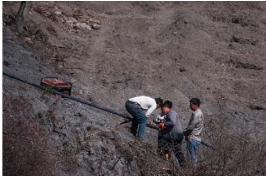
かんがい用パイプの敷設
