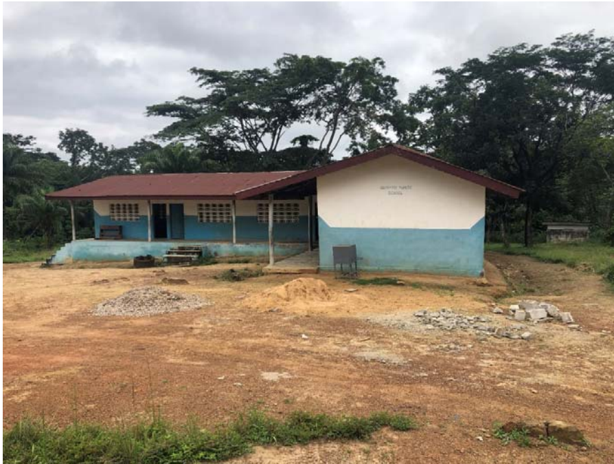
プロジェクト支援で改修した Gbobayee 小学校
