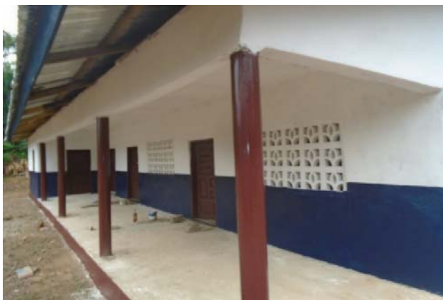
Yolowee 小学校での改修工事
