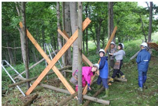
写真 2-7. 7月のワークキャンプでのツリーデッキ設置作業 (2019年7月6日)
