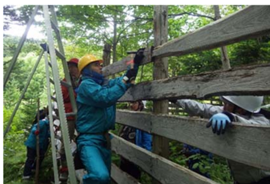
写真 1-8. 防鹿柵の補修（2019年9月20日）.
