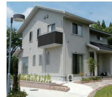
一般的な家庭での使用を想定して試験を行います
