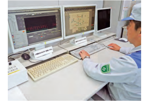
工場全体のエネルギーを、自社製品である「D-BIPS」 (注1) を使用し管理しています。エネルギーの見える化を推進し、全部門を対象とした省エネ活動を展開しています。 ※1 エネルギーを常時監視し消費電力のコントロールができるビル設備統合監視システム
