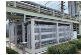
排水リサイクル設備導入による地下水汲み上げ量の削減取り組み
