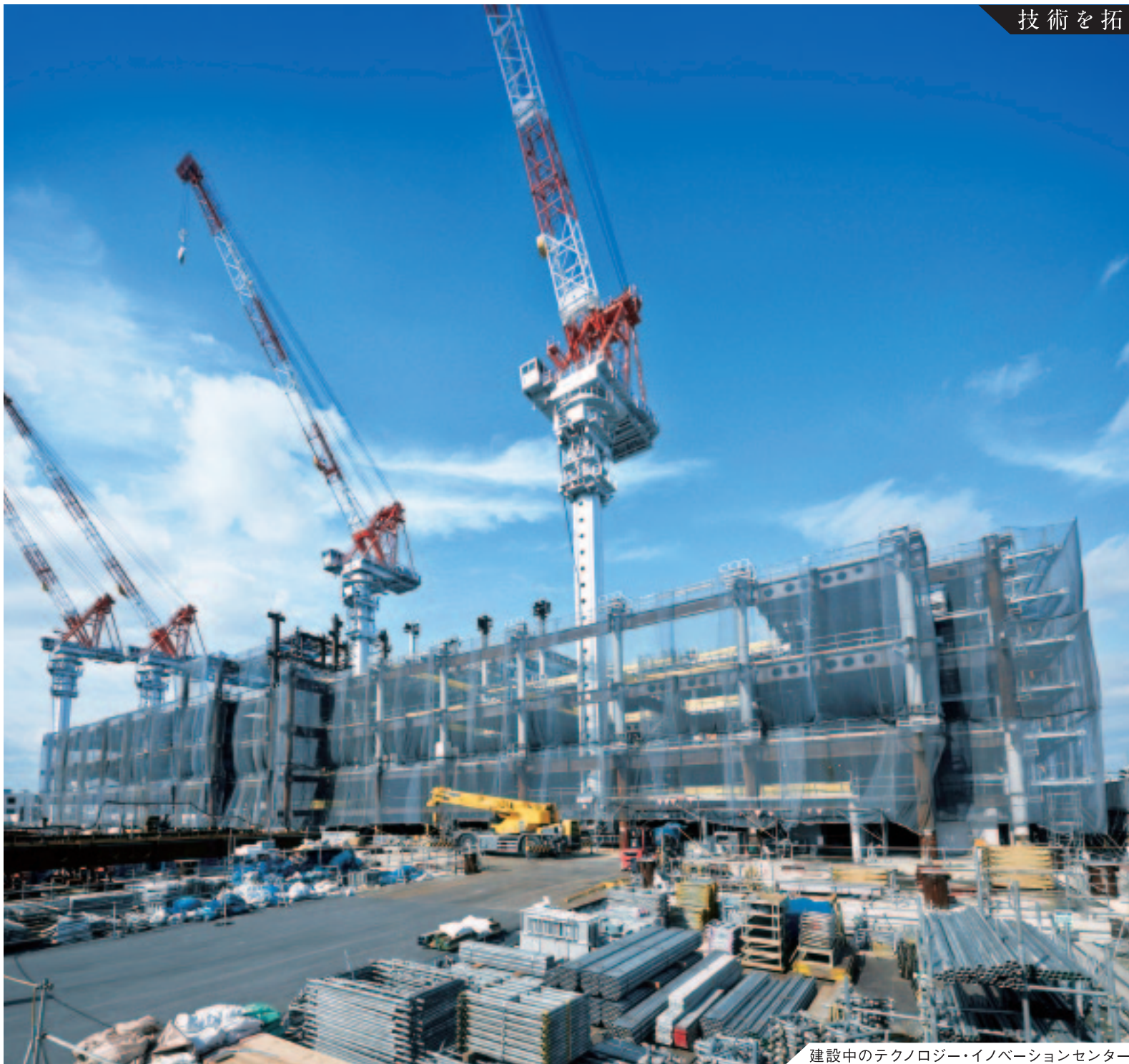
建設中のテクノロジー・イノベーションセンター
