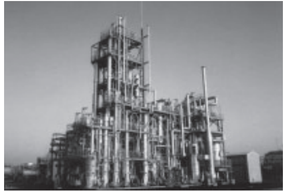
新冷媒 HFC134a 用プラント
