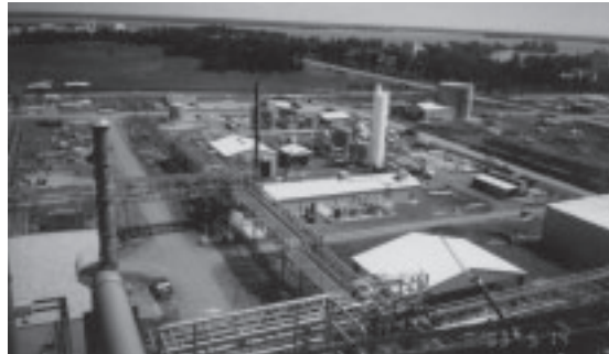
ダイキンアメリカ社のディケーター工場（第1期工事中）
