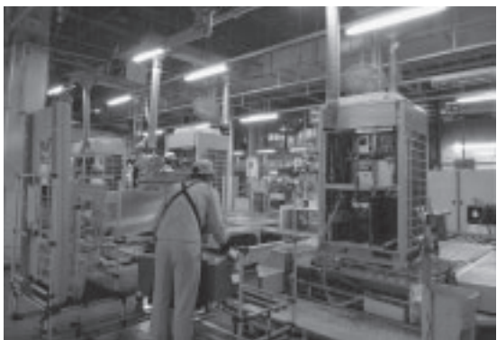
DIT 第2工場の内部
