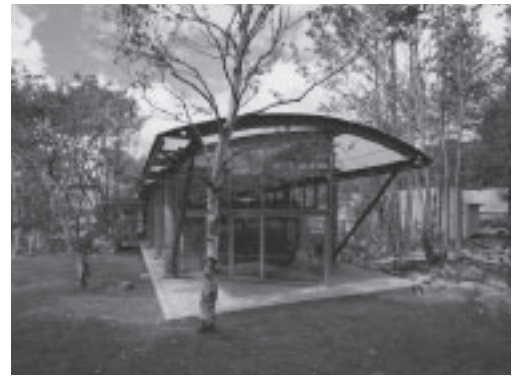
「ダイキン オー・ド・シエル蓼科」の入口（上）と、同センターハウス外観
