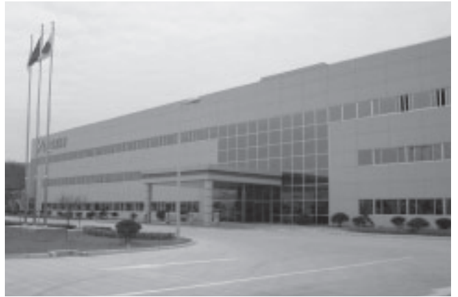
大金総合空調（上海）、大金中央空調（上海）の工場建屋
