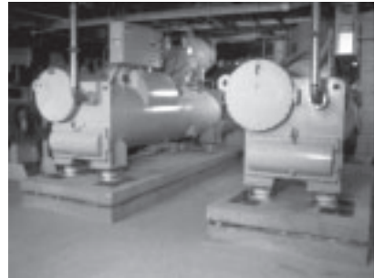
ロンドンのビクトリア駅（左）と同駅に納入した350冷凍トンのターボ冷凍機（右）
