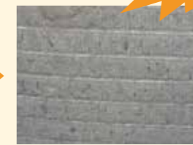
汚れが蓄積した空気熱交換器
