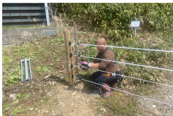
写真 2-10. 電気柵の立ち上げ作業の様子.
