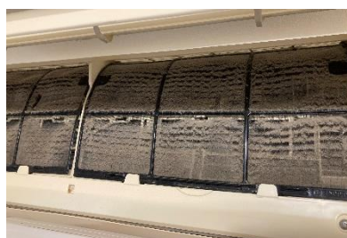
▲フィルター掃除なしの状態 約3年間掃除していないフィルターを使用
