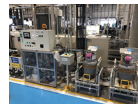
生産工程での冷媒回収の様子
