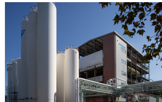
淀川製作所の冷媒再生設備。冷媒の再生・再利用によりライフサイクル全体で冷媒の環境負荷低減に貢献。
