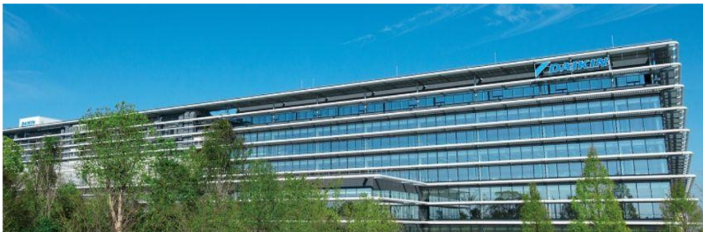
写真：テクノロジー・イノベーションセンター(大阪)
