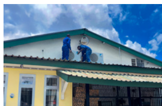
家屋への室外機取り付け
