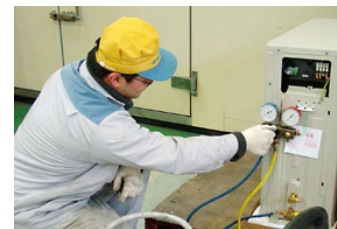
冷媒回収の様子
