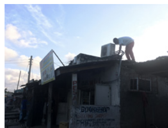
家屋への室外機取り付け
