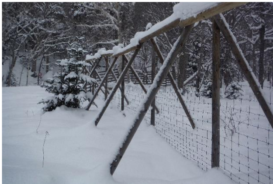
この秋に補修した岩尾別川沿いの防鹿柵(1月)
