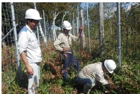
鉄柱とフェンスの取り付け作業（10月）
