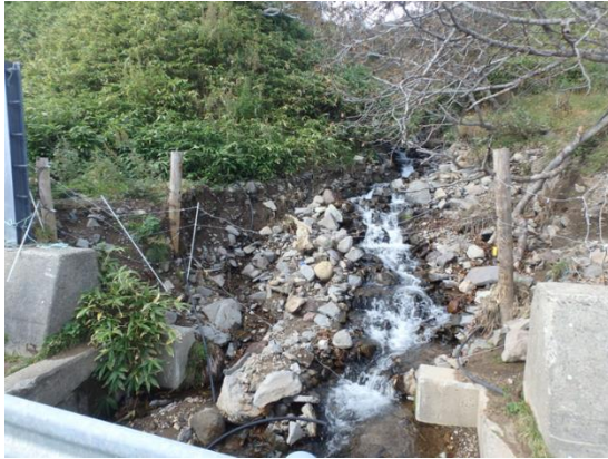
土砂崩れに巻き込まれた電気柵
