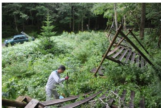
倒壊した防鹿柵（8月）
