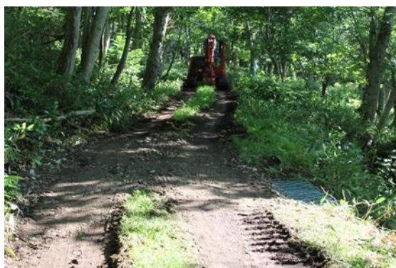
砂利を敷き均した後の作業道（7月）
