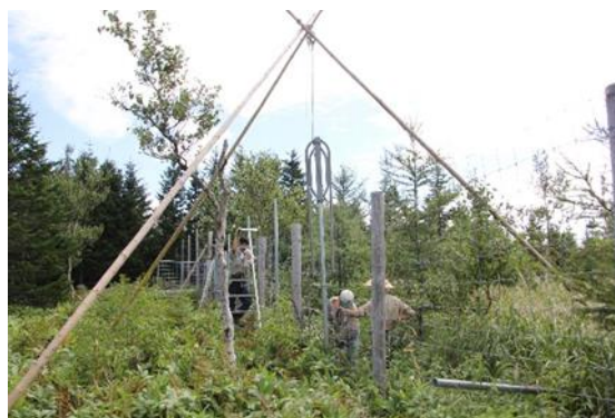
鉄柱の打ち込み作業（9月）
