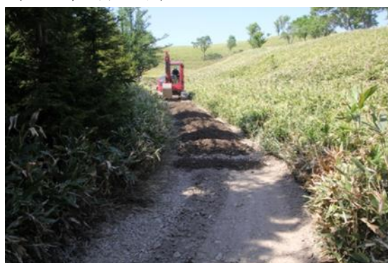
写真 1-6. 作業道整備の様子 (2018 年 6 月 19 日).
