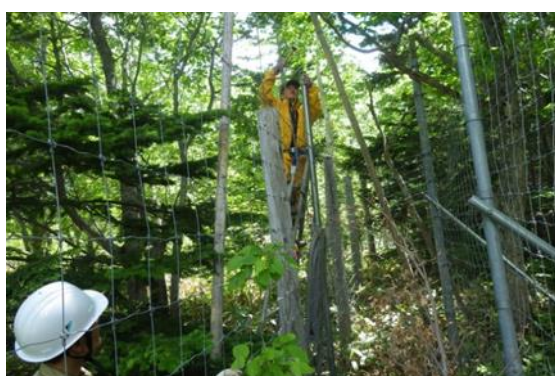
写真 1-5. 防鹿柵 (平成 15 年防鹿柵) での鉄柱の打ち込み作業 (2018 年 6 月 22 日).
