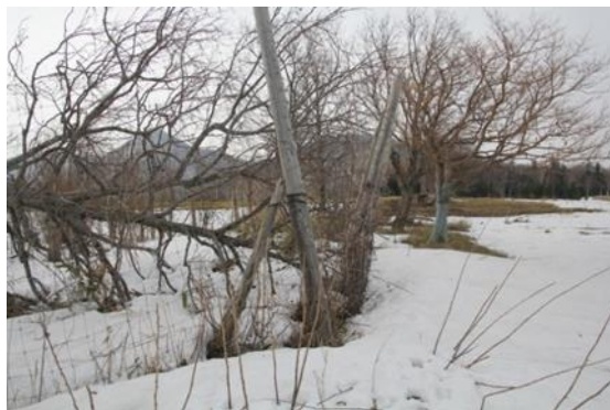
写真 1-1. 風と雪で折れた防鹿柵の柱（2018年4月3日）。
