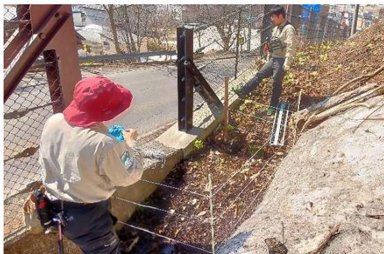
写真 3-1. 電気柵の立ち上げ作業の様子
