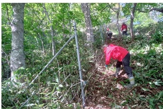
写真 3-3. 電気柵への雑草の接触による漏電を回避するための下草刈りの様子
