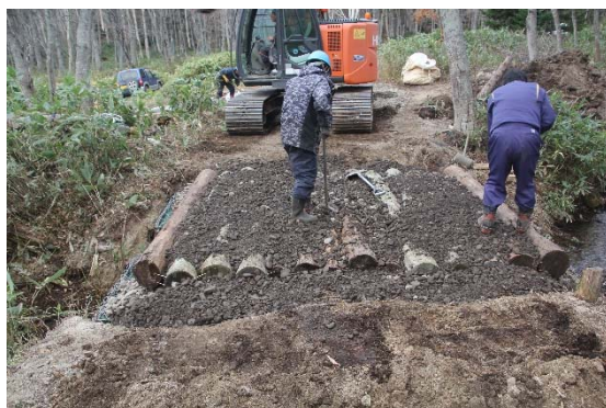
写真 1-5. 掛け替え作業中のポンホロ橋（2020 年 11 月 6 日）。
