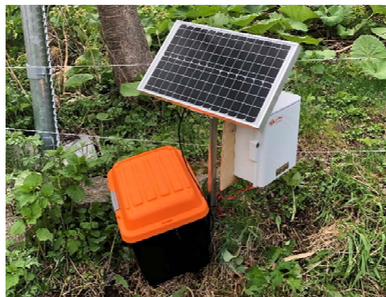
写真 2-8. 設置したEfMos（遠隔監視システム）.
