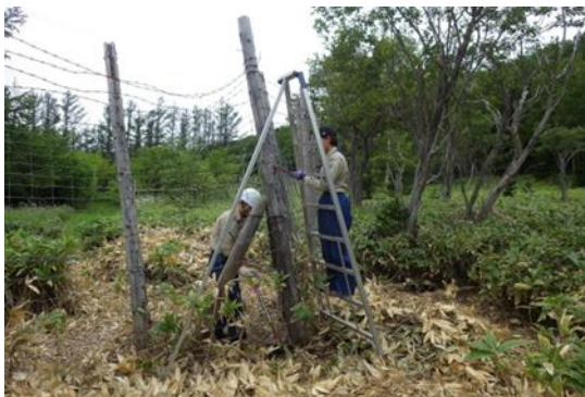
写真 1-3. 老朽化した防鹿柵の改修作業（2018 年 8 月 26 日）。
