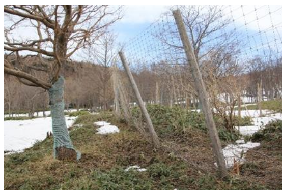
風と雪で折れた防鹿柵の柱(4月)
