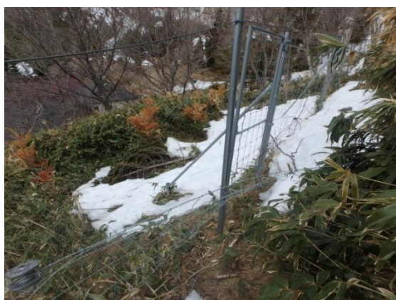
積雪の重みで壊れてしまった市街地北側電気柵
