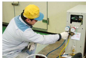
冷媒回収の様子
