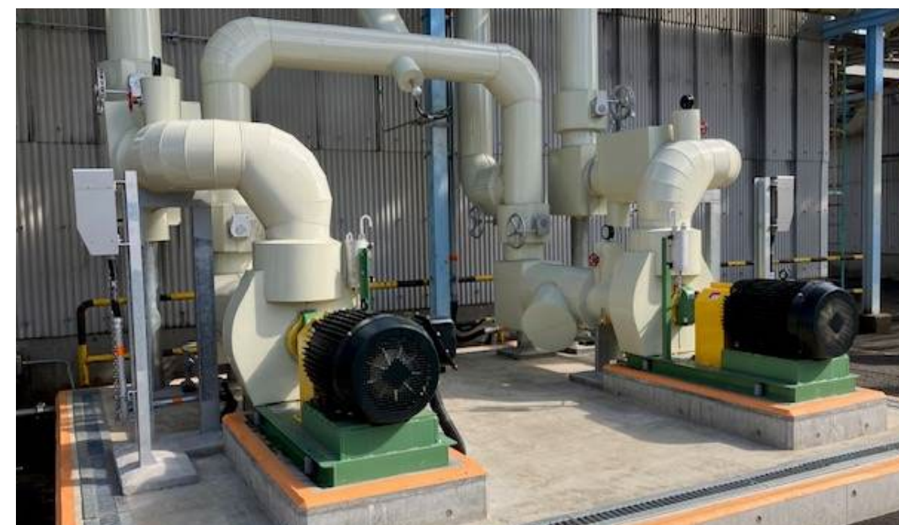
高効率モーターを使用したエコポンプ
