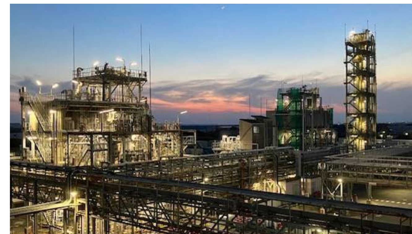
LED化したプラント架構照明
