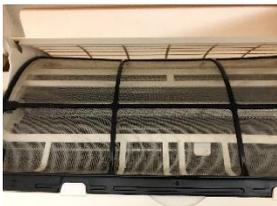
エアフィルターが汚れていると、室内の空気をエアコン内部に十分にに取り込めず、エアコンの能力が低下します。エアフィルターは、一見汚れていないように見えてもホコリが付着していることがあります。汚れが少なくても、2週間に一度のお掃除をおすすめします。
