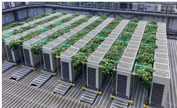
室外機芋緑化システムによって緑化した例（日本橋丸善東急ビル屋上）
