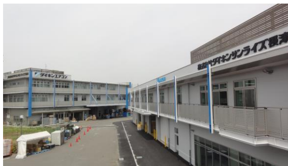
既存工場（左）と新事務所棟（右）
