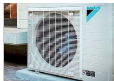
ミドルゾーンのインバータユニット『FIT』
