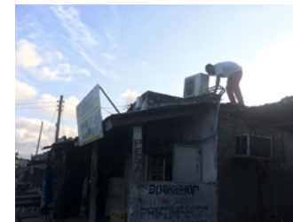
家屋への室外機取り付け
