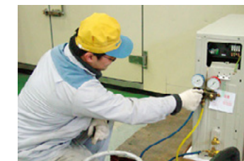
冷媒回収の様子
