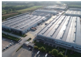
ダイキントルコ社の太陽光発電システム
