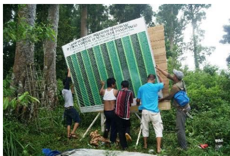
看板を修理中
