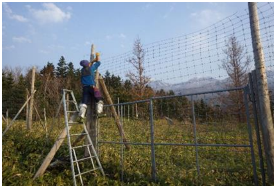
写真 1-3. 降雪前の防鹿柵の点検作業 (2017年11月7日)
