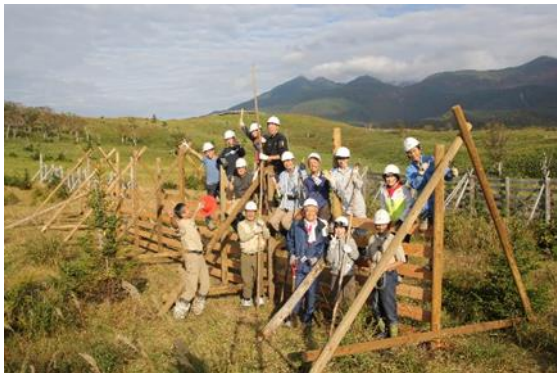
写真 1-9. 防風柵の設置作業(2017 年 9 月 24 日)
